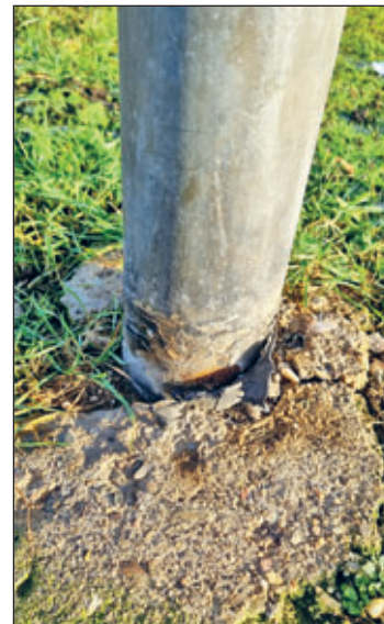
Abgebrannter Laternensockel - Platanenweg in Stauchitz
