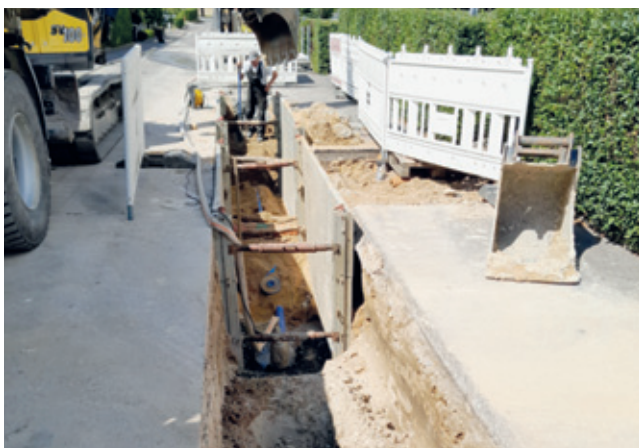
Der Rohrgraben in der Straße Am Sandberg.
