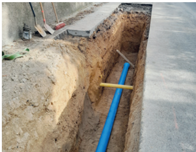
Der Rohrgraben an der Döbelner Straße.
